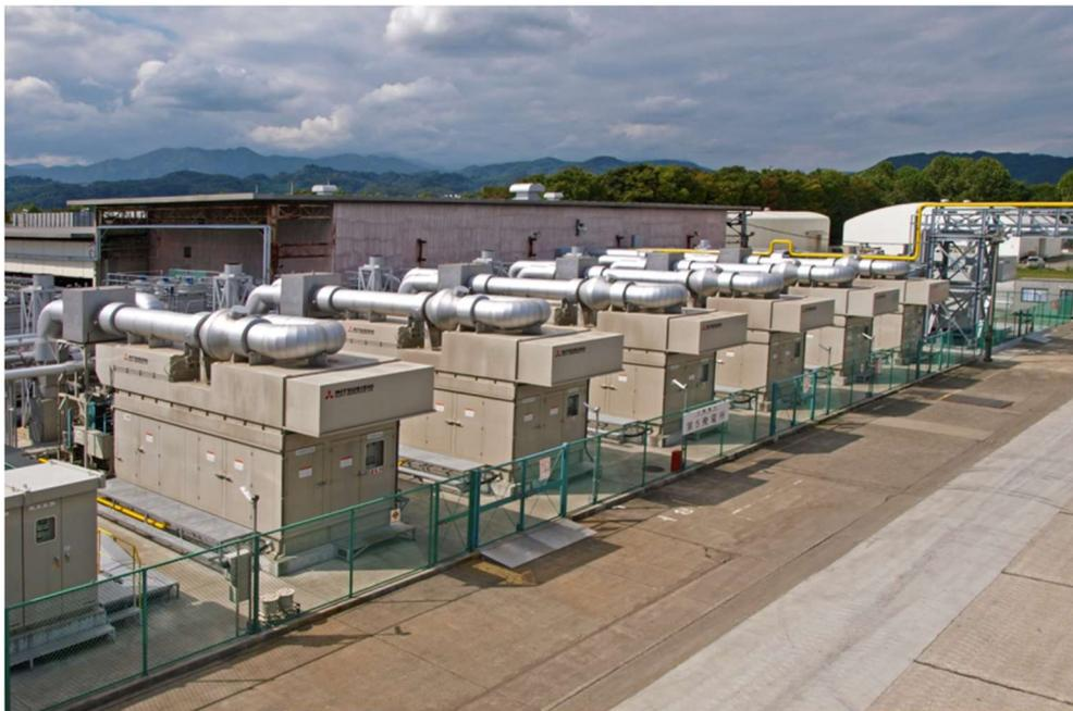
図6 三菱重工相模原製作所のガスエンジンコージェネレーション設備外観
